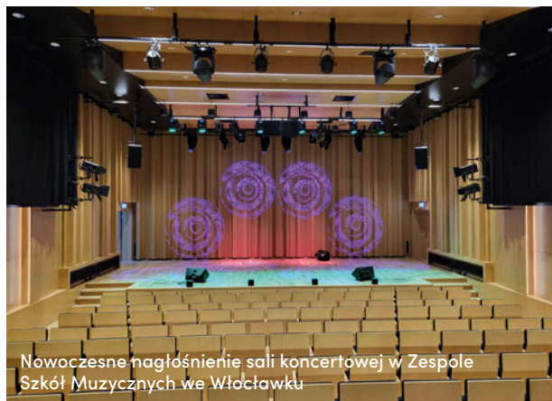
Zaawansowany system nagłośnienia wielofunkcyjnej wali widowiskowej w Centrum Kultury CEIK
