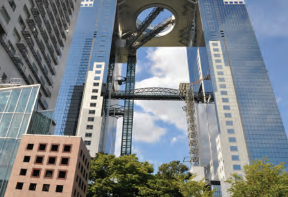
Osaka. Umeda Sky Building 173 m
