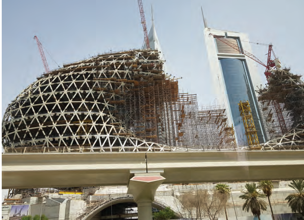
Dubaj. Konstrukcja nowego obiektu w budowie
