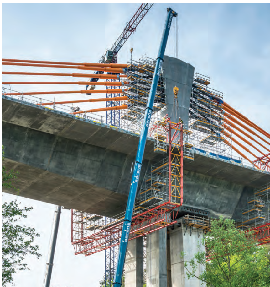
Fot. arch. PERI
