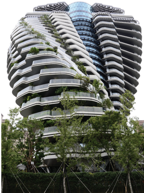
Rys. 6. Różne formy fasady w zależności od orientacji budynku (zdjęcie wykonane przez autorów)
