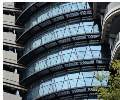
Rys. 8. Pomost komunikacyjny w fasadzie trzonu budynku (zdjęcie wykonane przez autorów)
