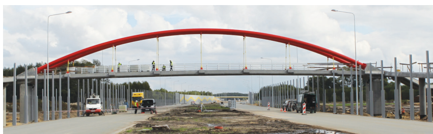
Rys. 2. Widok z boku kładki nad drogą S8
