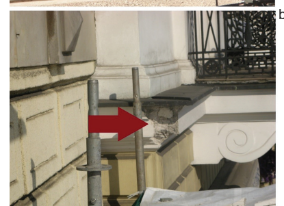
Fot. 6. Uszkodzenia tynków na gzymsach: a) objawy uszkodzenia; b) zachowanie się tynku po uderzeniu młotkiem
