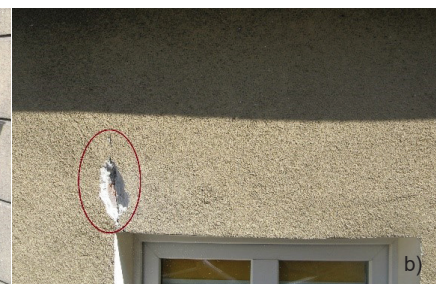
Fot. 3. Spękania tynku w pobliżu oparcia nadproża: a) spękanie tynku cementowo-wapiennego; b) rysa w konstrukcji nadproża (po dokonaniu odkrywki)
