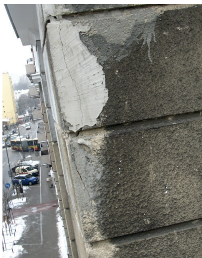
Fot. 8. Odpadające uzupełnienia ubytków tynków
