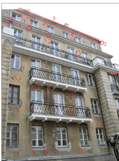
Fot. 9. Przykładowy opis stanu technicznego tynków elewacyjnych budynku wraz z zaleceniami w protokole pokontrolnym
