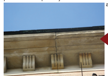
Fot. 5. Uszkodzenia tynków na powierzchniach poziomych
