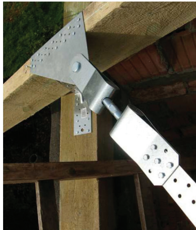
Fot. 7. Złączka ściągająca (śruba rzymska) w połączeniu z końcówką [8]
