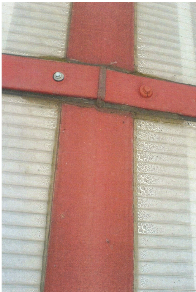
Fot. 5. Wykroplona para wodna pod czaszą świetlika
