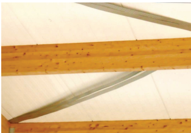
Fot. 4. Stężenie wiatrowe z widocznym zwisem
