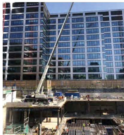
9. Platforma robocza w poziomie -1 użytkowana przez koparki, żurawie kołowe, pompy do betonu i inne urządzenia
