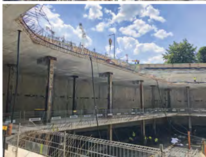
6. Obudowa wykopu podparta stropami rozporowymi i lokalnie rozporami stalowymi
