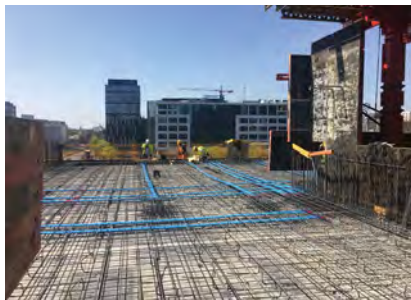
7. Montaż kabli sprężających w stropie
