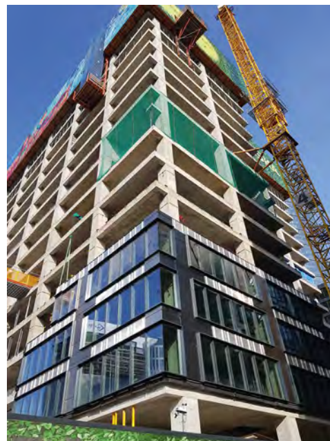
3. Widok ogólny budynku w trakcie realizacji – sky-office za zieloną siatką
