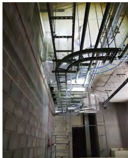
5. Montaż instalacji na poziomie -1
