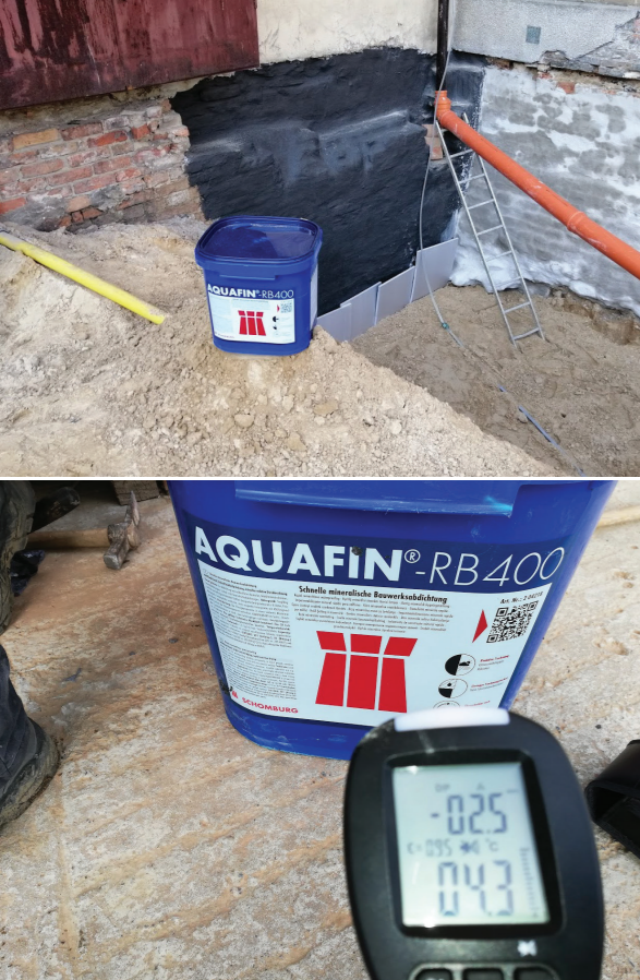
Izolacja tarasu w temperaturze poniżej 5°C. Czas wiązania ok. 60 min
