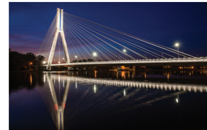
Pomiarami przemieszczeń objęto także przęsto mostu im. Tadeusza Mazowieckiego w Rzeszowie. Zainstalowano łącznie 600 metrów trasy światłowodowej, uzyskując 6 000 punktów pomiarowych!
