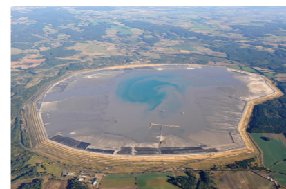
Największy w Europie zbiornik odpadów poflotacyjnych „Żelazny Most”, (foto: Archiwum KGHM PM SA), w obrębie którego zainstalowano czujniki 3DSensor
