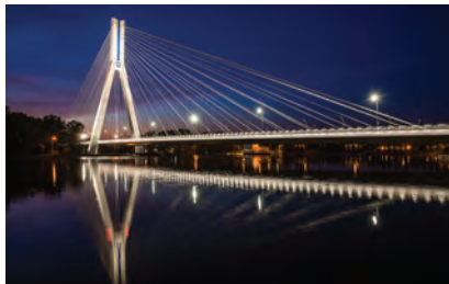
Pomiarami przeszczeń objęto także przeszło mostu im. Tadeusza Mazowieckiego w Rzeszowie. Zainstalowano łącznie 600 metrów trasy światłowodowej, uzyskując 6 000 punktów pomiarowych!
