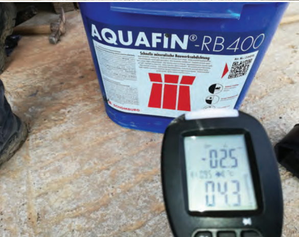
Izolacja tarasu w temperaturze poniżej 5°C. Czas wiązania ok. 60 min
