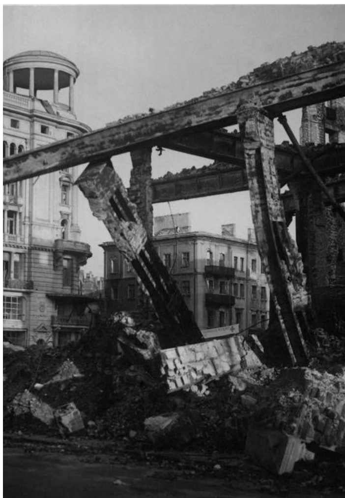
Na pierwszym planie ruiny spalonego Hotelu Europejskiego, w głębi zachowany w lepszym stanie hotel Bristol, 1945 rok In the foreground, ruins of the burnt Europejski Hotel; in the background, the Bristol Hotel, preserved in a better condition, 1945
