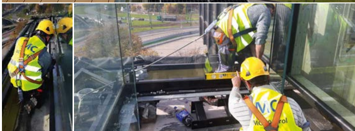
Podesty techniczne okalające taras widokowy .KTW wykonywane przez MC Control™
