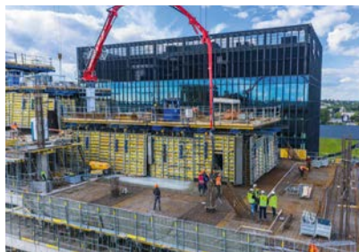
Fot. arch. Doka
